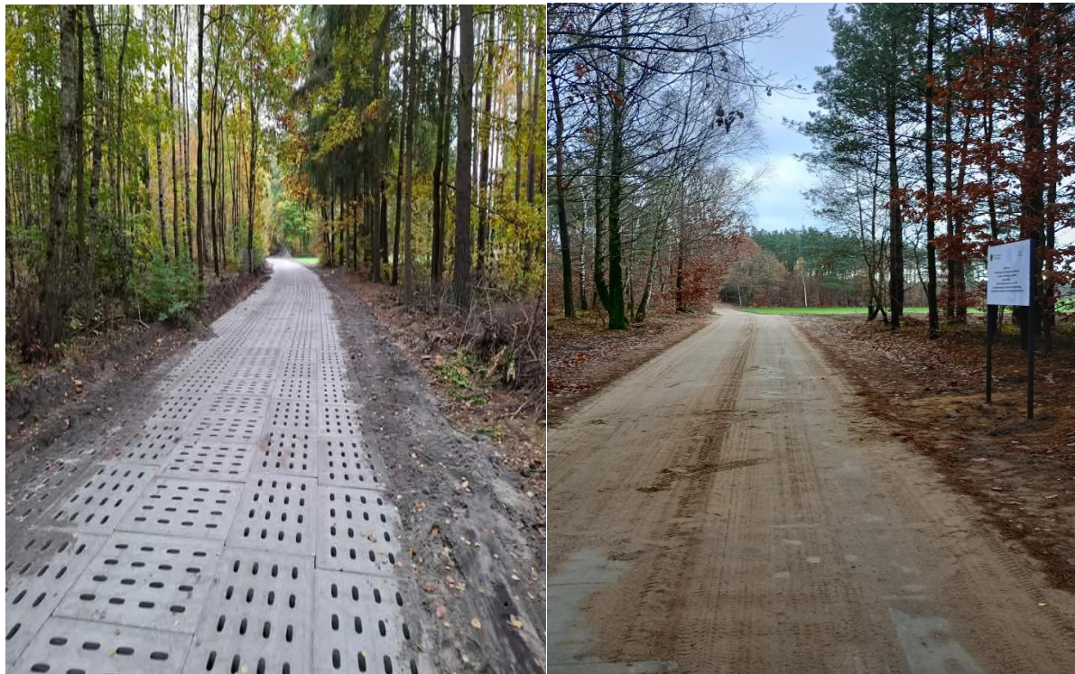
Utwardzenie płytami YOMB odcinka drogi pomiędzy miejscowością Frank a miejscowością Łązek
