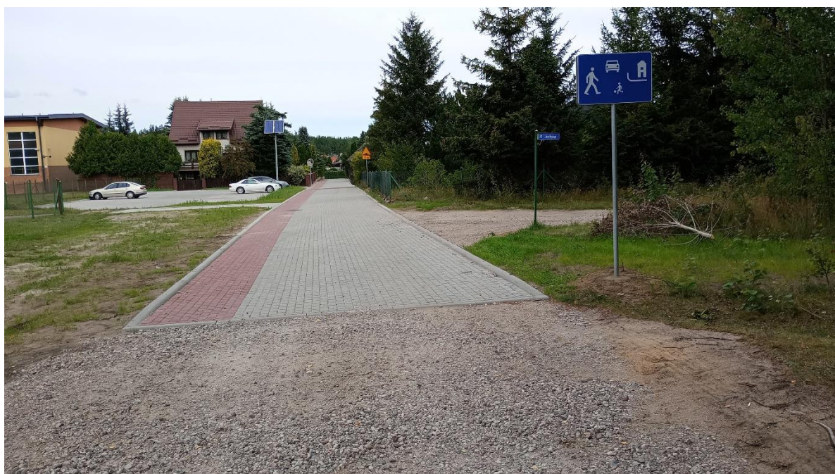
Utwardzenie ulicy Sportowej w Kaliskach
