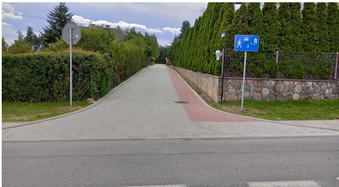
Utwardzenie ulicy Sportowej w Kaliskach
