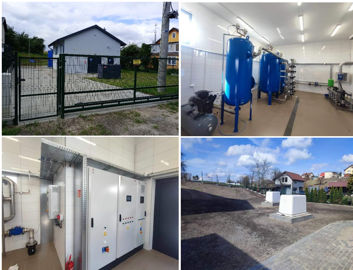
Zmodernizowana Stacja Uzdatniania Wody w miejscowości Piecie
